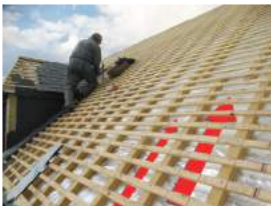
Création d'une lame d'air ventilée en sous-toiture avec un gain de 9°C par rapport à la situation initiale en laine de verre.
