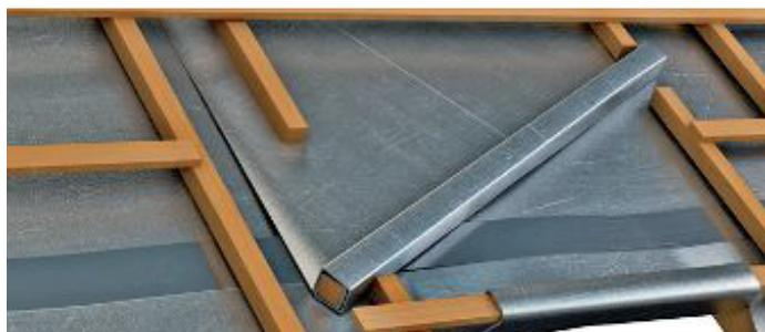
Une bande de parement supérieur du **SKYTECH PRO XL**, soigneusement séparée du reste de l'écran, de largeur égale à l'entraxe des chevrons augmentée de 20 cm est découpée. Cette bande est glissée dans le recouvrement directement situé en amont du chevêtre. Un liteau est ensuite entouré dans la bande (au moins de 2 tours complets). Ce liteau entouré est ainsi utilisé comme déflecteur. Il est disposé en biais en amont des contrelattes interrompues et enfin il est cloué.
