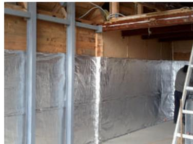
Se pose seul ou avec un isolant en sous face
