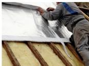
Pose en contact direct avec l'isolant
