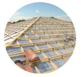
Ecran de sous-toiture conforme au marquage CE 13859-1.
